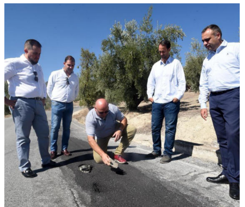
Visita a la carretera de Loja. DIPGRA
