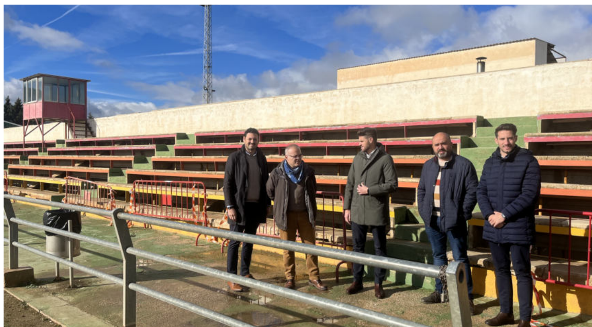
Graderío de la pista de atletismo de Baza. DIPGRA
