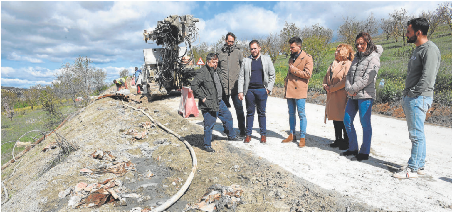
Obras de estabilización vial en el municipio de Moclín. DIPGRA
