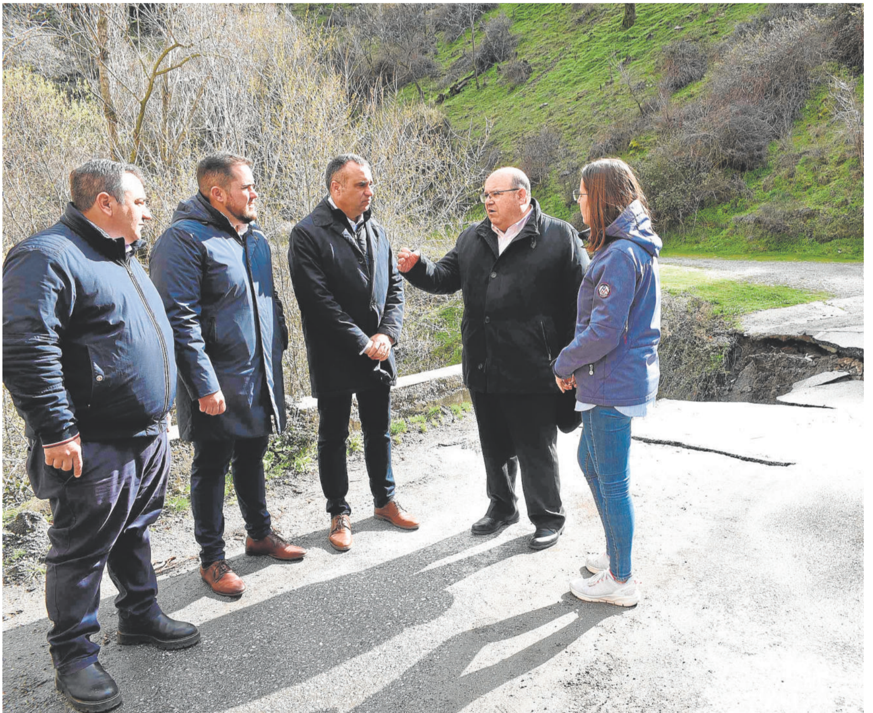
El presidente de la Diputación visita Güéjar Sierra tras afectar las lluvias al puente sobre el río Maitena. DIPGRA
