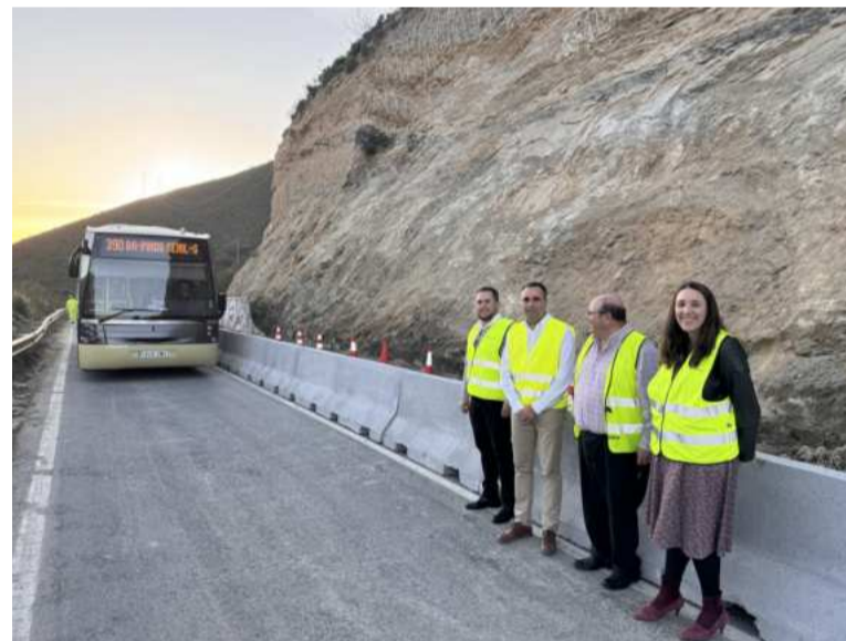
Reapertura de la vía afectada por lluvias en Güéjar Sierra. DIPGRA
