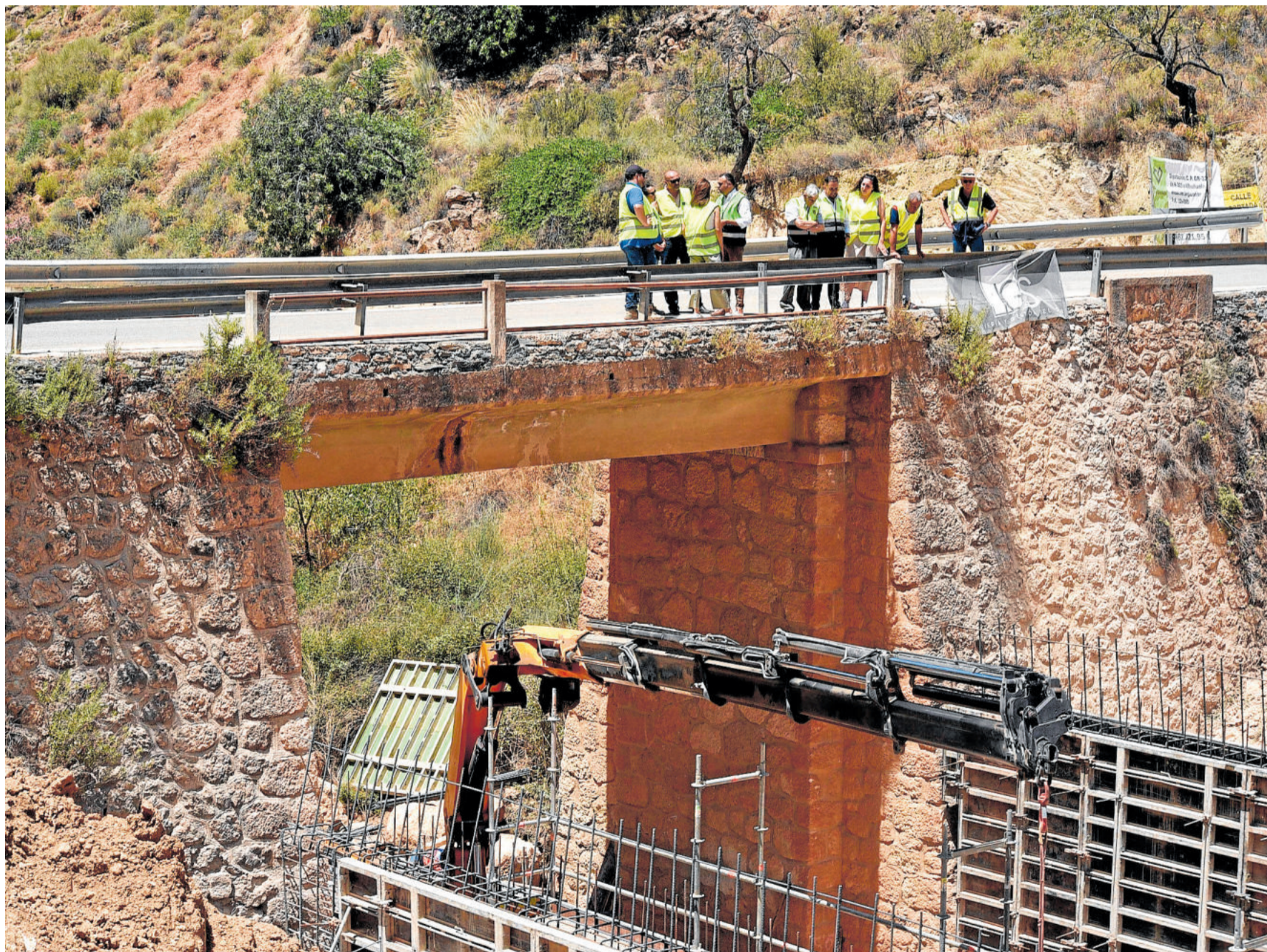
El presidente de la Diputación supervisa el avance de las obras que se están llevando a cabo en el puente de las Albuñuelas. DIPGRA
