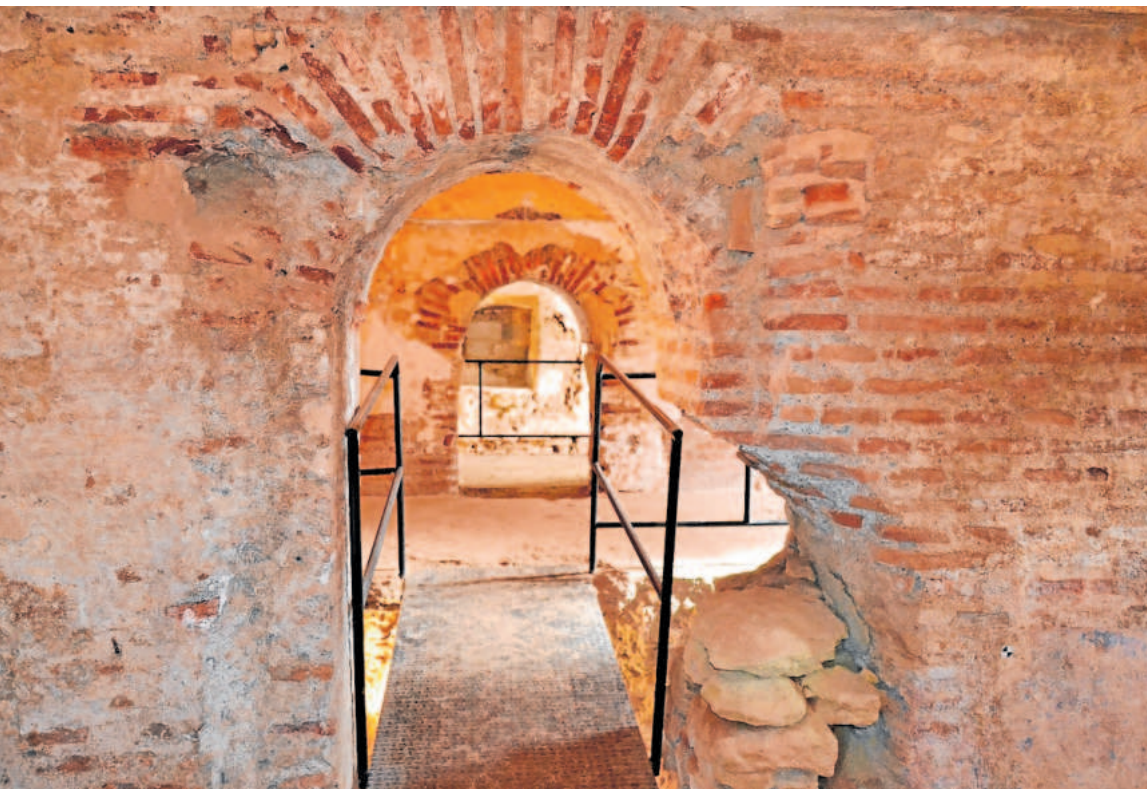
Los baños árabes se encuentran actualmente embutidos en el interior de una vivienda. I.C.
