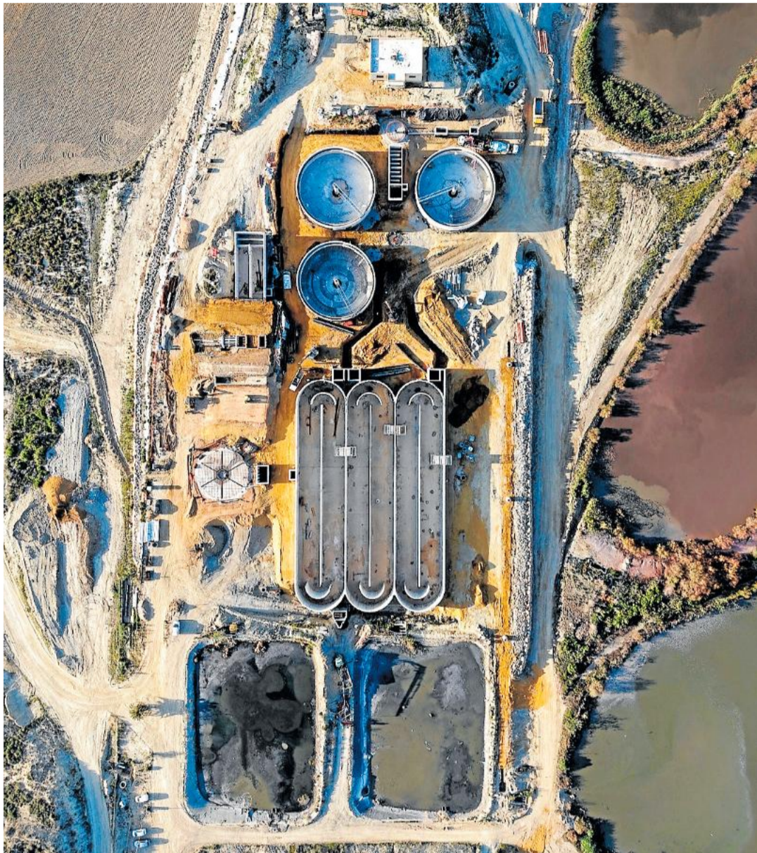
Estación Depuradora de Aguas Residuales de Mojácar. Albaida
