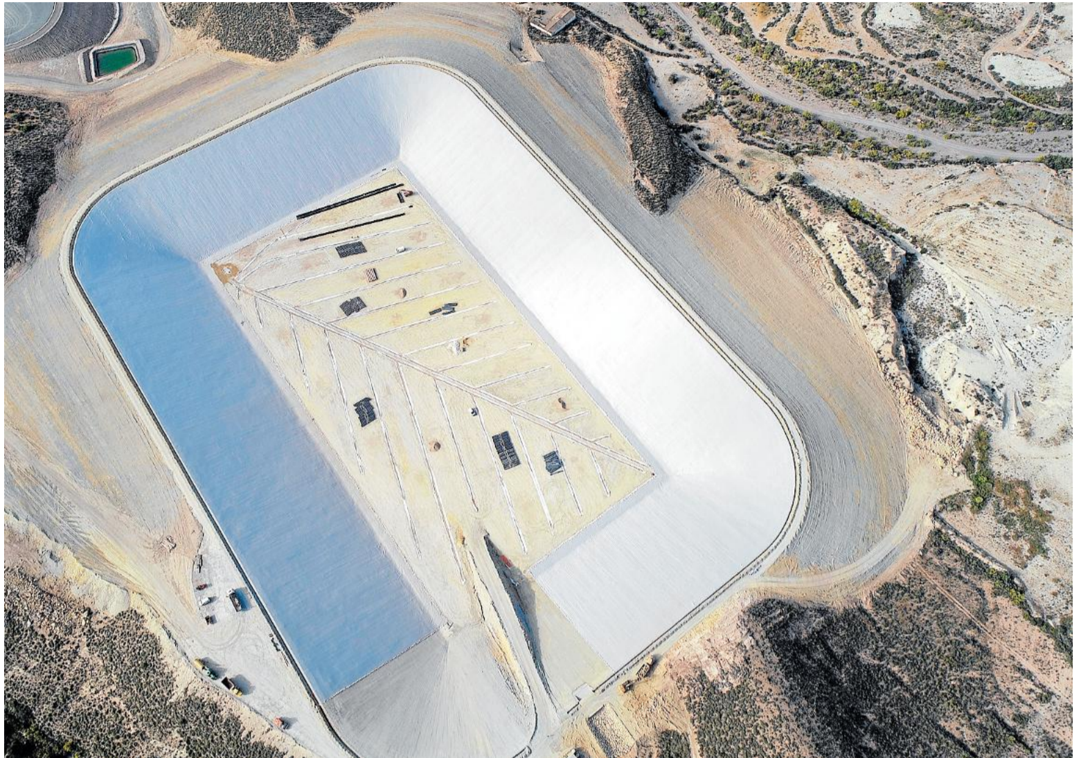
Imagen aérea tomada a comienzos de mes para constatar el estado de la ejecución de la obra de la balsa Las Morlas de Níjar. CUCN
